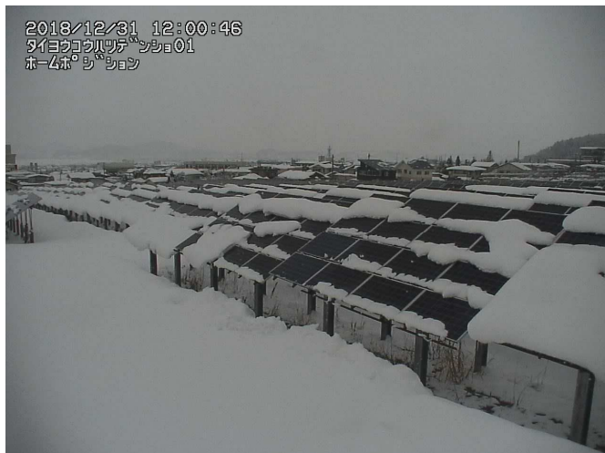
平成30年12月31日 12:00 太陽光発電所の状況
