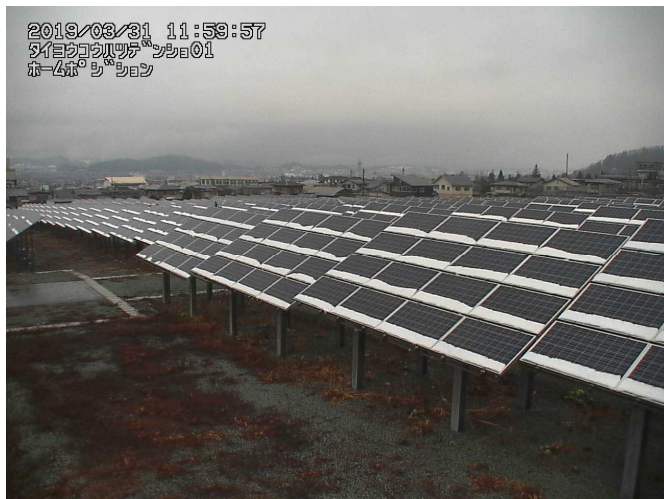
平成31年3月31日 12:00 太陽光発電所の状況
