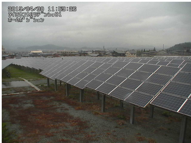
平成31年4月30日 12:00 太陽光発電所の状況
