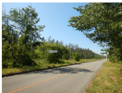
国道112号沿い危険木 [伐採後]
