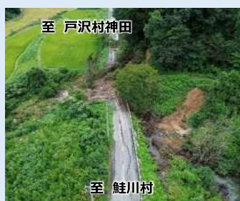
被災時（撮影：R6.7月）
