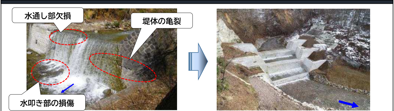
砂防設備（破損した砂防えん堤の改築）
