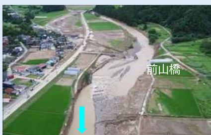
被災時（浸水被害状況）（撮影：R6.7月）
