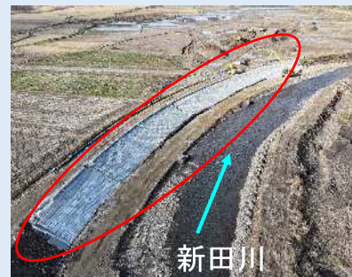
工事中（撮影：R7.12月）
