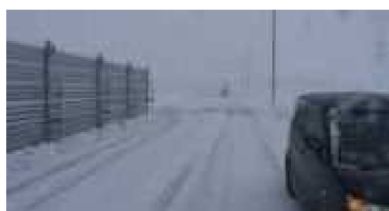
（整備後：防雪柵設置完了）
