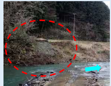
橋梁撤去 完了（撮影：R7.12月）
