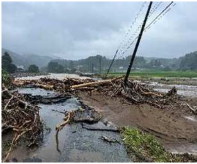
浸水被害 状況
