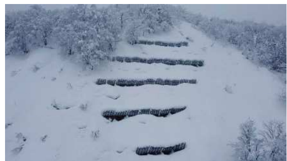
（整備後：雪崩予防柵設置完了）
