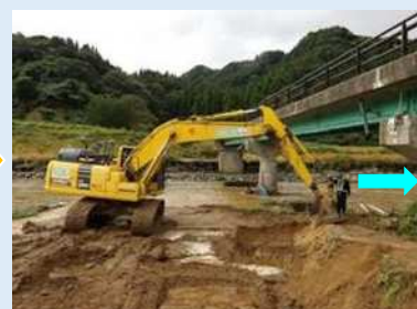
河道掘削 工事中（撮影：R7.10月）
