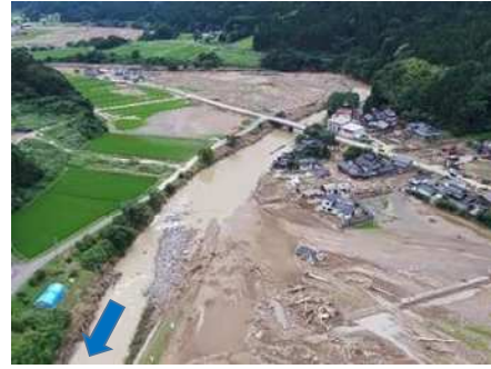
河岸浸食・浸水被害 状況
