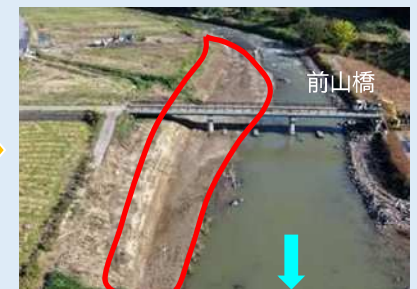
河道掘削 完了（撮影：R7.10月）
