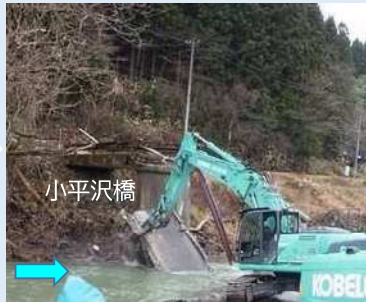
橋梁撤去 工事中（撮影：R7.12月）
