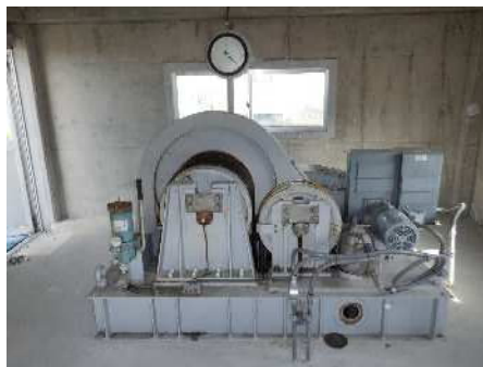
機械設備の補修
