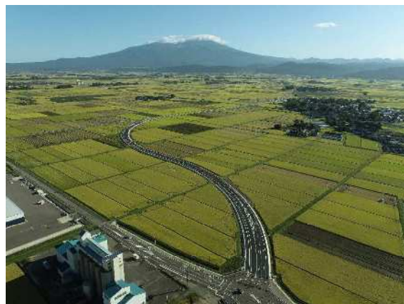
(国) 344号 (安田バイパス工区) (R7.10.4供用開始)
