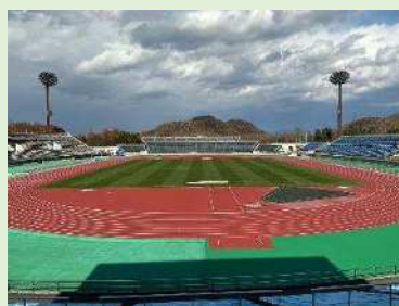
トラック改修(R7完了)
