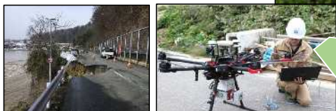
被災箇所の点群データを取得
