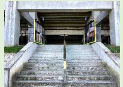
ゲート改修(R6完了)
