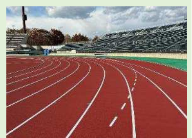
トラック改修(R7完了)
