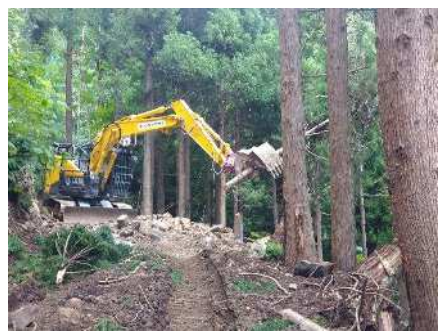
森林作業道の開設状況
