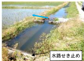
水路をせき止めて用水確保 (水管理が困難な状況)
