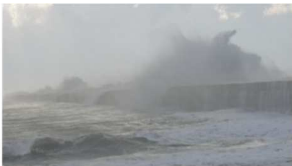
冬季風浪により入・出港障害や荷役障害が発生 (R5年度:63回、R6年度:56回)
