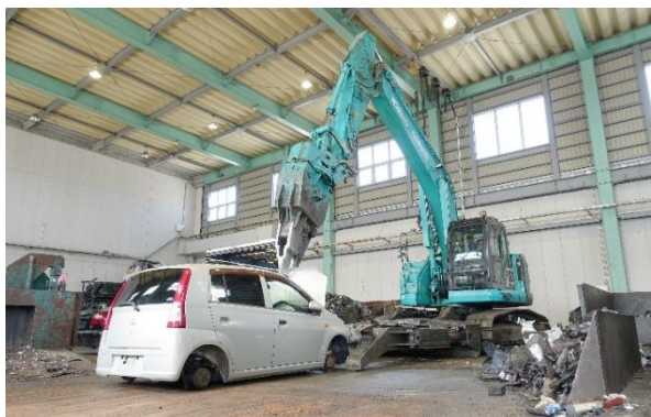
人の手とマルチ解体機を組み合わせた精緻な解体
