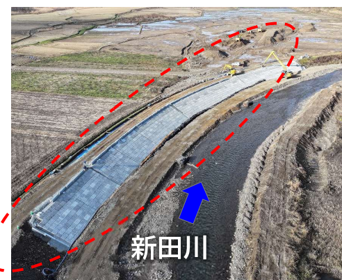
災害復旧工事
