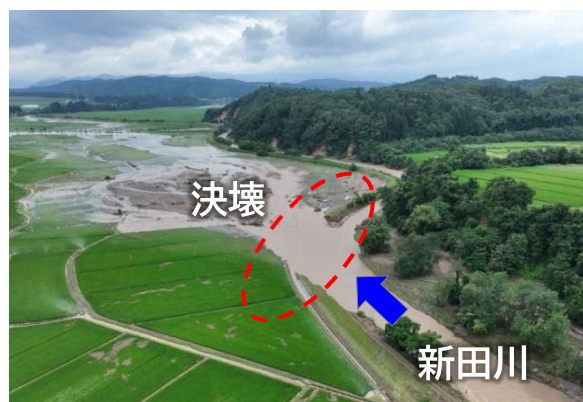
堤防決壊（令和6年7月）
