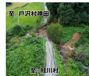
被災時（撮影：R6.7月）
