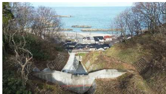
みずかみ沢砂防えん堤(鶴岡市)
