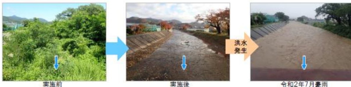
▲日塔川(東根市) 令和元年度実施 堆積土砂撤去
