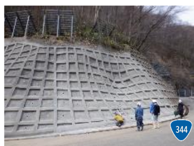
崩落箇所を修復
