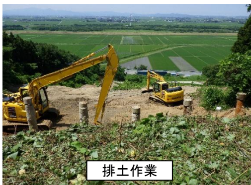
酒田市山寺字待楯地内 地すべり防止施設復旧工事中
