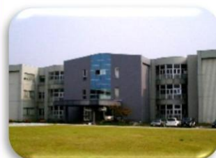
実験研究棟 環境工学実験室
