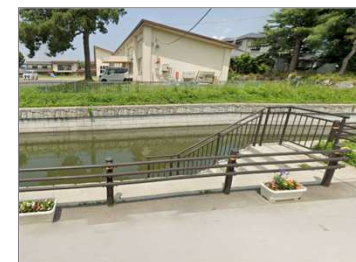
▲ 下水道(雨水調整池)整備
