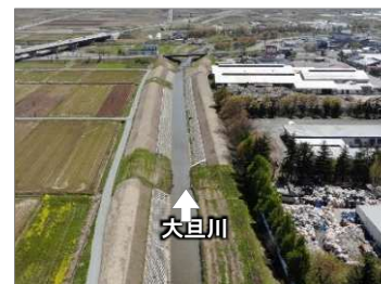
▲ 河川整備（築堤）
