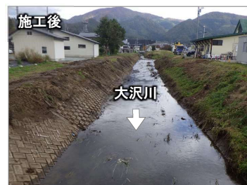
▲ 河川整備（浚渫）
