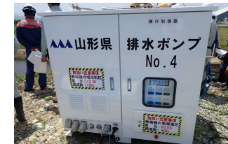
▲ 排水ポンプの整備（山形県）
