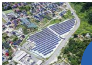
太陽光発電所
