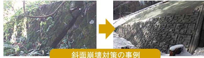
斜面崩壊対策の事例
