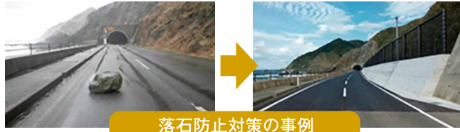
落石防止対策の事例
