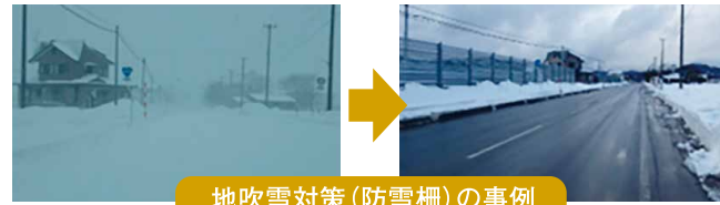
地吹雪対策(防雪柵)の事例
