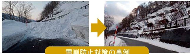
雪崩防止対策の事例
