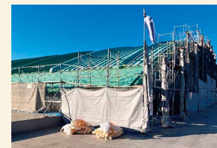
山形県総合運動公園【天童市】 総合体育館屋根改修
