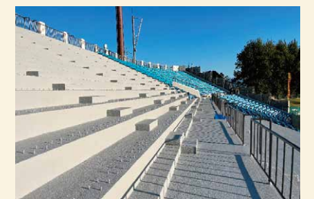
中山公園【中山町】 野球場躯体防水工事
