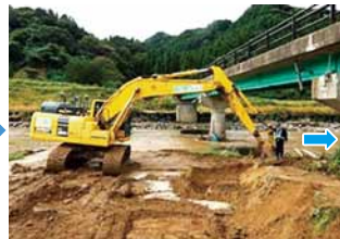
河道掘削 工事中 (撮影：R7.10月)
