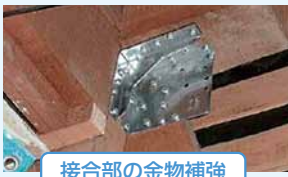
接合部の金物補強
