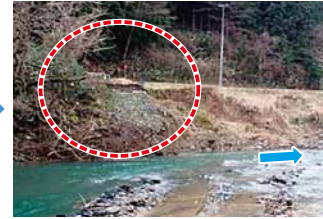
橋梁撤去 完了(撮影：R7.12月)
