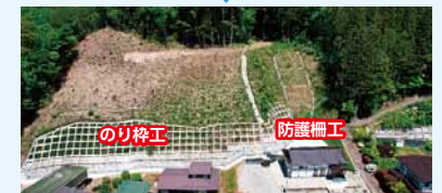
対策後(R6.5 完成)
