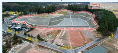
対策後(R6.12 完成)
