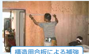
構造用合板による補強
