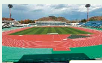
トラック改修 (R7完了)
