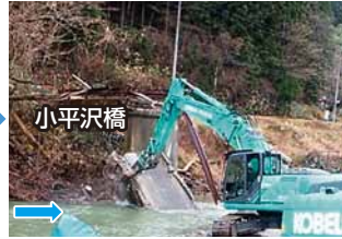
橋梁撤去 工事中(撮影：R7.12月)
