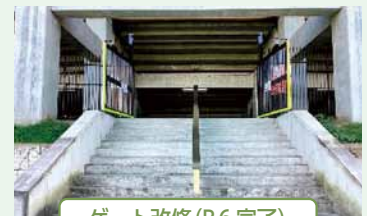
ゲート改修 (R6完了)
