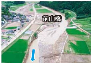
被災時(浸水被害状況) (撮影：R6.7月)
