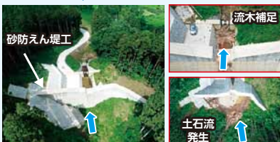
対策後(R5.3 完成)
