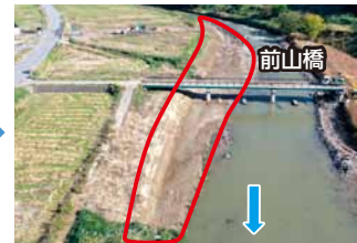
河道掘削 完了 (撮影：R7.10月)
