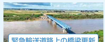
緊急輸送道路上の橋梁更新
