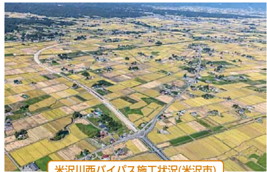
米沢川西バイパス施工状況(米沢市)
