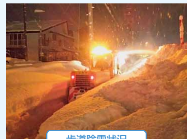
歩道除雪状況
