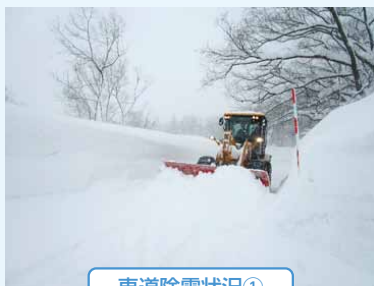
車道除雪状況①
