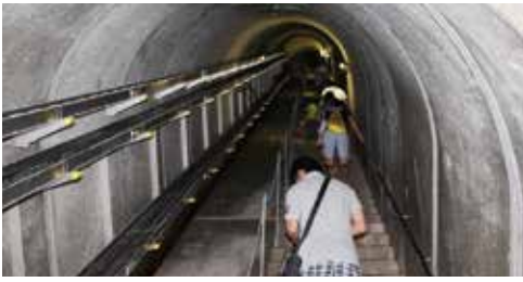
ダム内部見学状況
