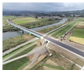
国道47号新庄古口道路
