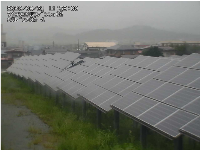
令和2年8月31日 12:00 太陽光発電所の状況
