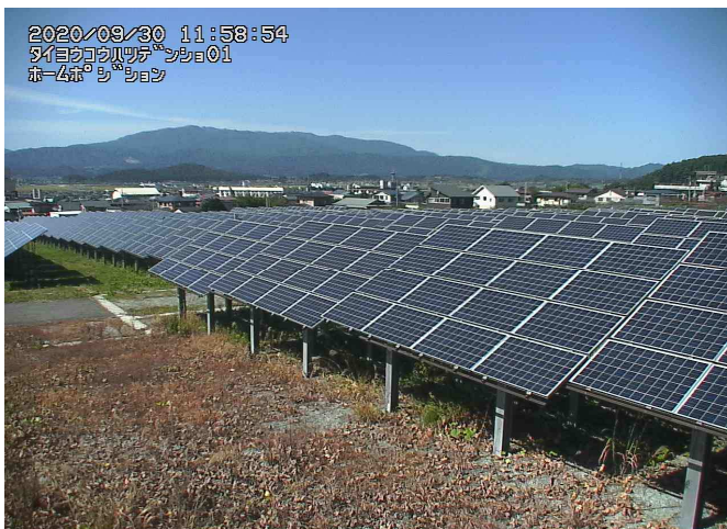
令和2年9月30日 12:00 太陽光発電所の状況
