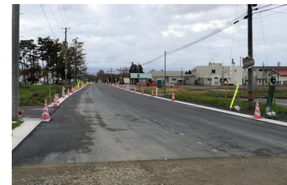
【県道309 拡幅工事】
