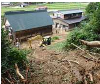
(民家裏の山腹崩壊)
