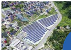
太陽光発電所
