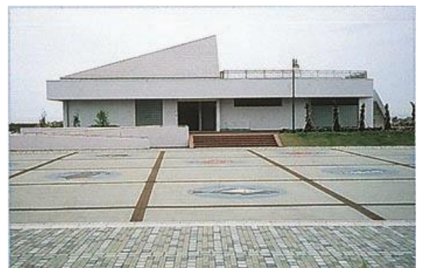
トイレ・シャワー棟
