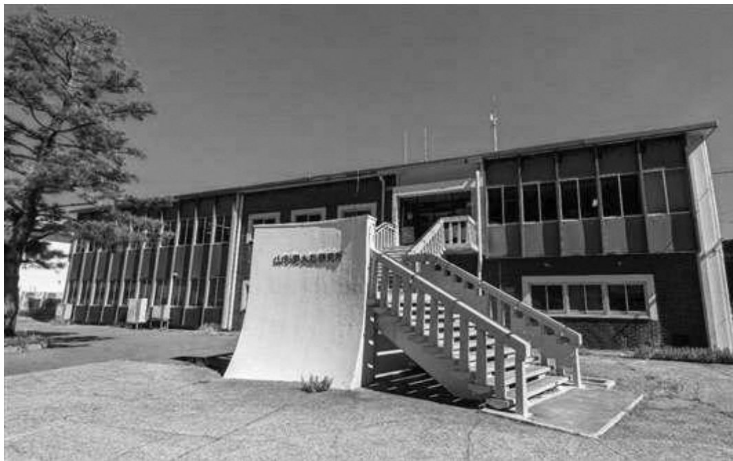
(写真：施設全景)
