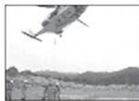
消火パケット取付作業
