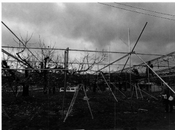
筋交い設置状況
