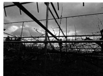
アーチ設置状況
