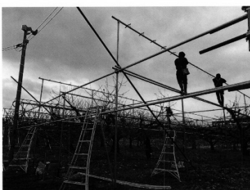
棟パイプ設置状況
