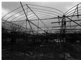
アーチ設置状況
