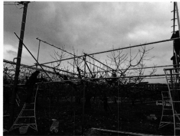
柱・梁設置状況
