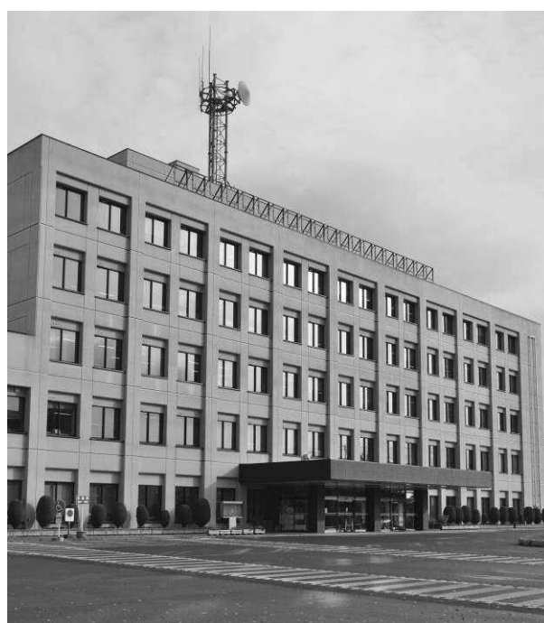
置賜総合支庁本庁舎
