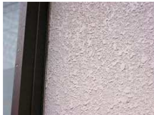
モルタル壁+吹き付け
