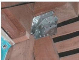
接合部の金物補強
