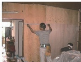
構造用合板による補強
