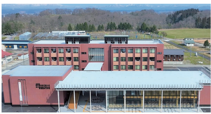
東北農林専門職大学校舎新築工事
