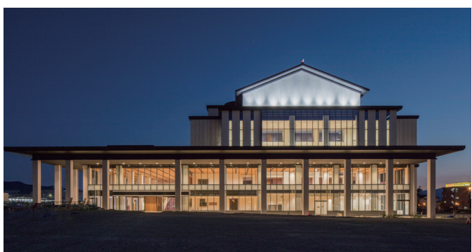
山形県総合文化芸術館新築工事
