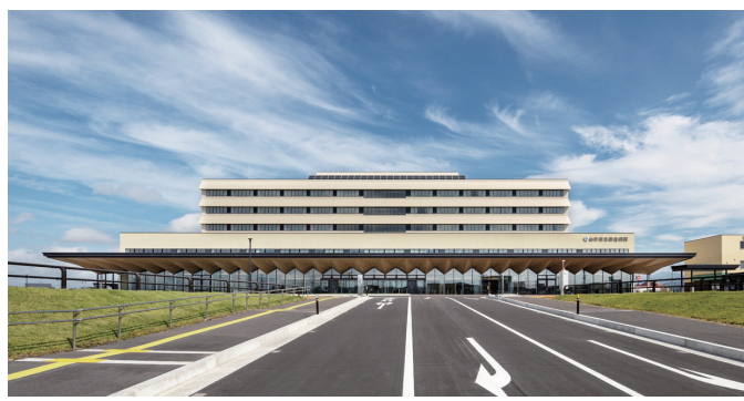
山形県立新庄病院改築整備事業
