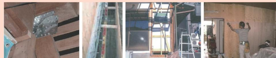
接合部の金物補強 基礎の補強 筋交いによる補強 構造用合板による補強
